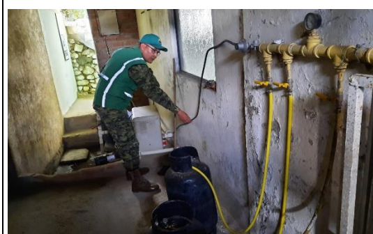
Inspecciones de seguridad
